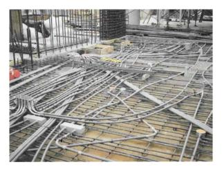
Figure 9-5 - Embedded conduit.
