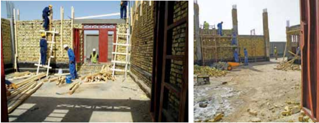
أعمال إنشاء في مشروع مسلخ البصرة الحديث
