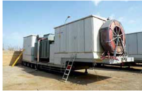
المحطات الفرعية جهد ١١/٣٣ كيلو فولت و قاطراتها الخارجية في مرفق مستودع وزارة الكهرباء الخارجي في الرمادي
