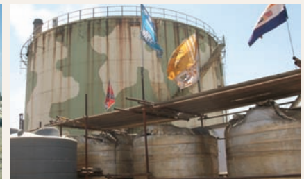
محطة كهرباء الدورة
