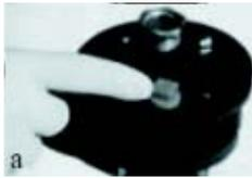
Determine el tipo de pozo que usted tiene y cómo vaciar el blanqueador dentro del mismo. Algunos pozos tienen un sello sanitario que pueden tener una apertura de ventilación o un tapón que se puede quitar (a). Si su pozo fue excavado o barrenado, la tapadera completa se puede quitar para crear un espacio para verter el blanqueador dentro del pozo (b).
