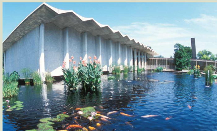
二十世纪六十年代建成的行政办公大楼，其设计风格呼应了树木既垂直向上又向四周开枝散叶的结构特点。
