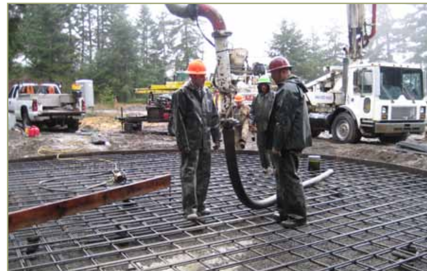
Concrete pour for the water storage tank.
